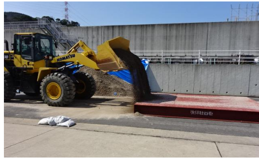
段差復旧状況
