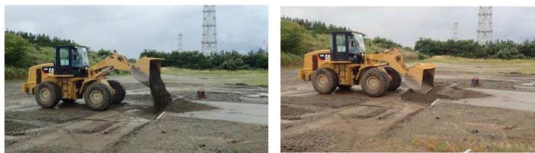
段差復旧状況①
