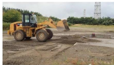
段差復旧状況③
