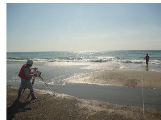
海岸線地形測量実施状況 (汀線部)
