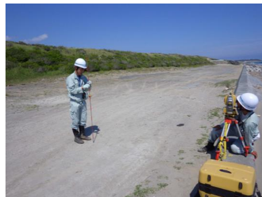
海岸線地形測量実施状況 (陸上部)
