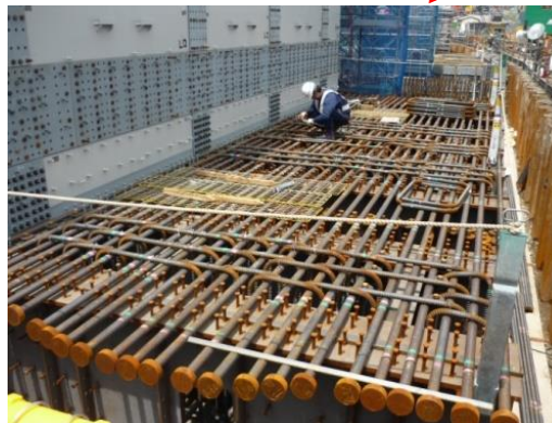
フーチング組立状況
