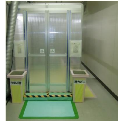
第6図 チェンジングエリアの外観
