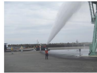
放水砲による放水 (噴霧放射)
