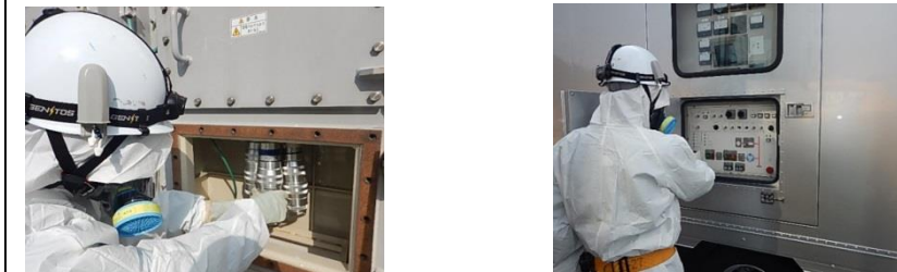
第4図 放射線防護具類を着用した状態での高圧発電機車のケーブル敷設作業
