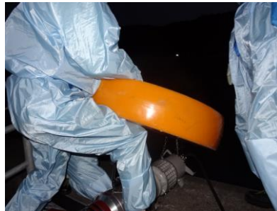
水中ポンプ設置準備（夜間）
