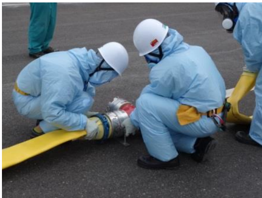
ホース接続作業（昼間）
