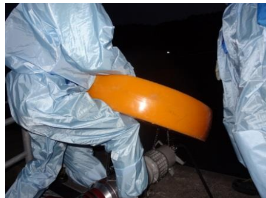
水中ポンプ設置準備（夜間）
