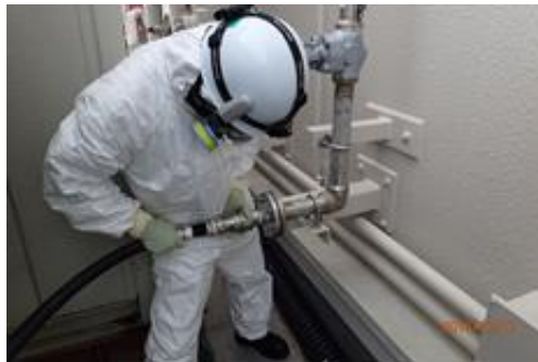
ホース接続作業
