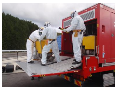
水中ポンプ設置準備
