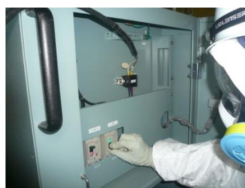
主蒸気逃がし安全弁用 蓄電池の負荷投入作業
