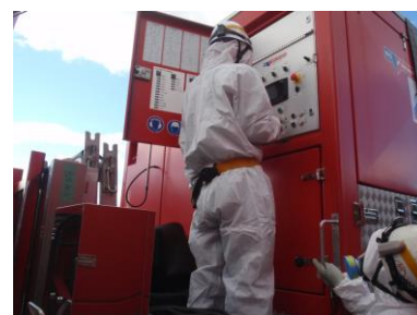
ポンプ起動操作
