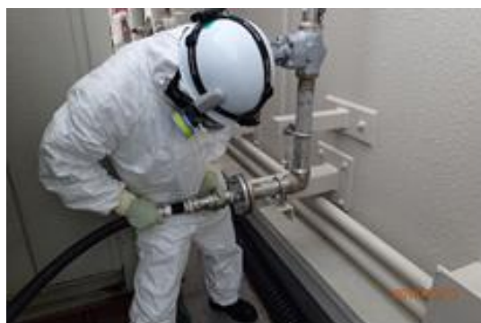
ホース接続作業
