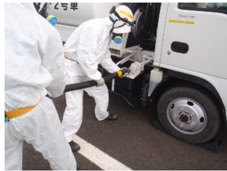
タンクローリへの燃料ホース接続
