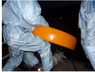
水中ポンプ設置準備（夜間）
