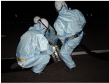
ホース接続作業（夜間）
