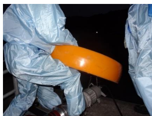
水中ポンプ設置準備（夜間）
