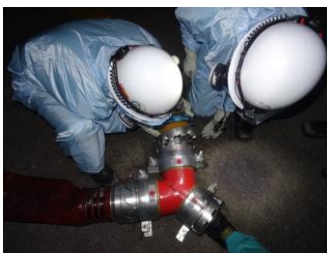
ホース接続作業（夜間）
