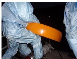
水中ポンプ設置準備（夜間）
