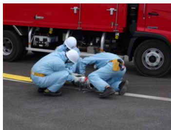
ホース接続作業（昼間）
