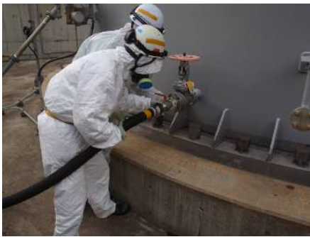
ガスタービン発電機用軽油タンクへのホース接続
