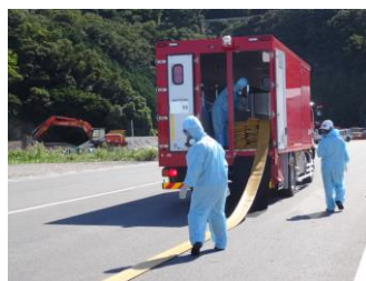
ホース展張作業（昼間）
