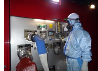
ポンプ起動操作（夜間）
