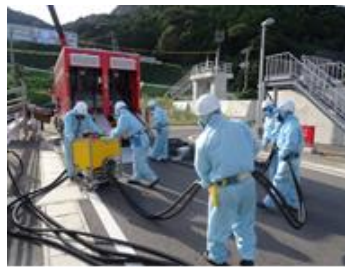
水中ポンプ設置準備（昼間）
