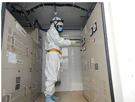
直流給電車での作業
