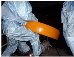
水中ポンプ設置準備（夜間）
