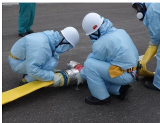
ホース接続作業（昼間）
