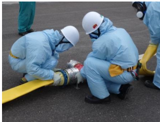
ホース接続作業（昼間）
