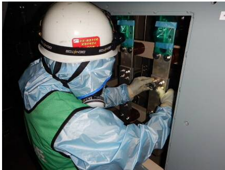
ボルトリンク接続作業
