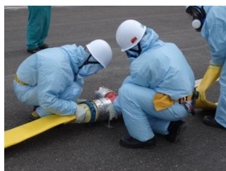
ホース接続作業（昼間）
