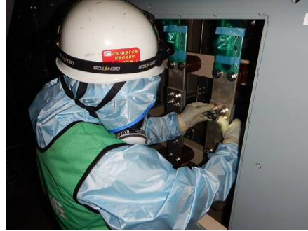
ボルトリンク接続作業
