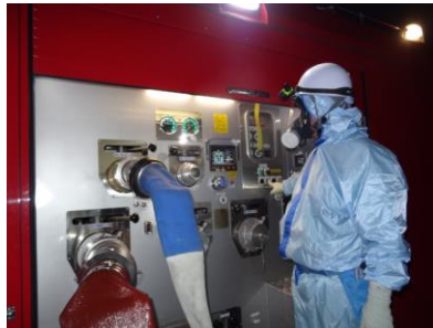
ポンプ起動操作（夜間）
