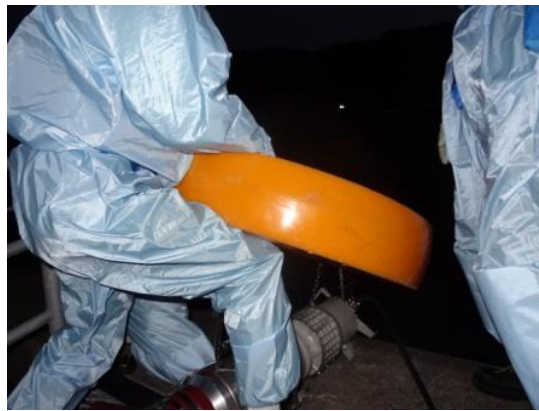
水中ポンプ設置準備（夜間）
