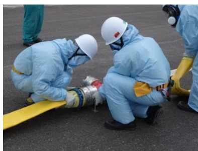
ホース接続作業（昼間）
