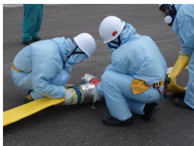
ホース接続作業（昼間）
