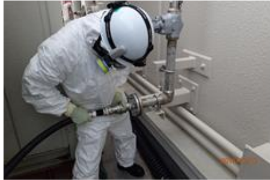
ホース接続作業
