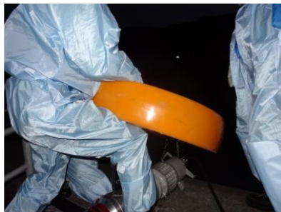
水中ポンプ設置準備（夜間）
