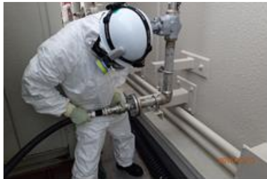
ホース接続作業
