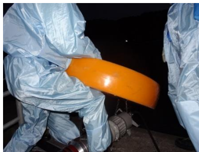
水中ポンプ設置準備（夜間）
