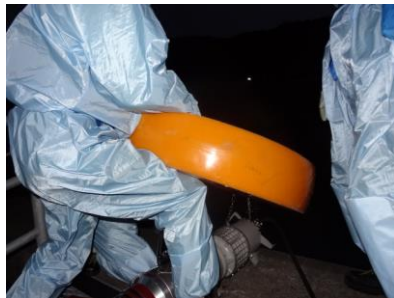
水中ポンプ設置準備（夜間）
