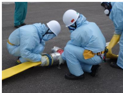
ホース接続作業（昼間）
