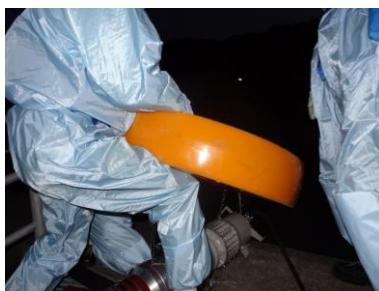
水中ポンプ設置準備（夜間）
