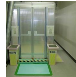
図 3.3-6 チェンジングエリアの外観
