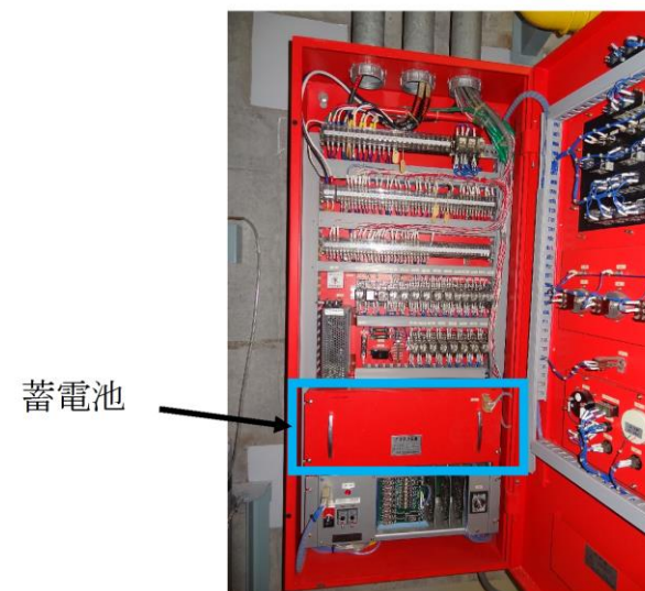
第 41-1-24 図 消火設備の電源確保の概要
