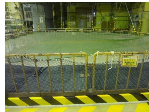
図2 大物搬入口外観
