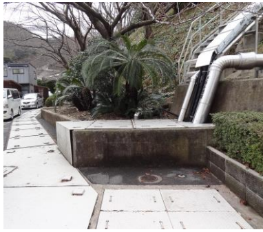
第 41-1-28 図 屋外消火配管への保温材設置状況
