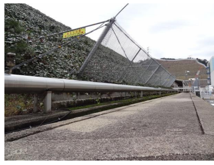
第 41-1-28 図 屋外消火配管への保温材設置状況
