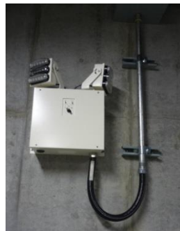
消火用非常照明（壁掛け型）の設置例
