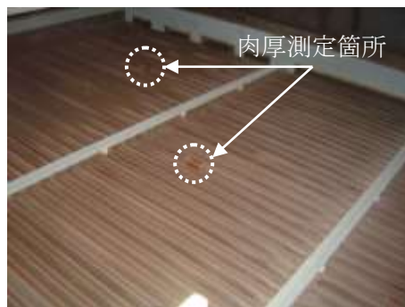
(主冷却器伝熱管外観)
