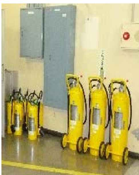
第 1 図 特殊化学消火材を装填した可搬式消火器
