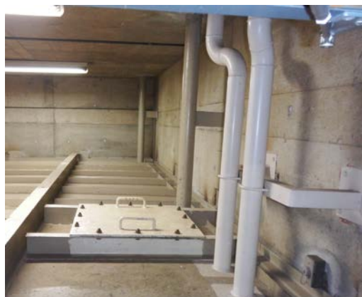
(ナトリウム溜の蓋の写真 (通常閉止))
