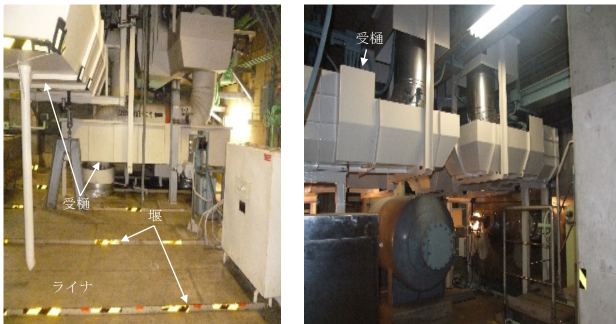
第1図 鋼製のライナ又は受樋の一例
