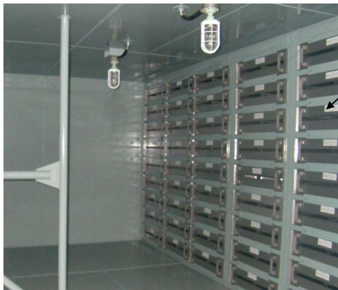
フィルタ（非常用）取付状態
