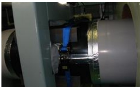
③ 修復完了
