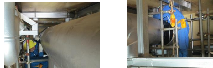
第2図 狭隘部作業状況
