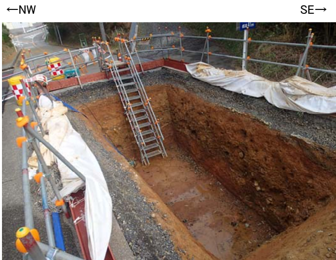
トレンチ状況写真(南西側から撮影)
