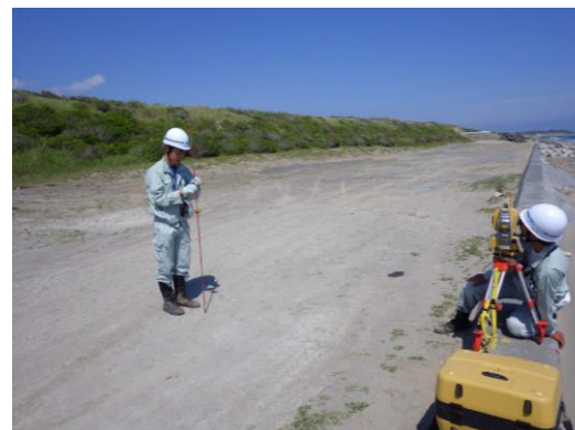
海岸線地形測量実施状況 (陸上部)
