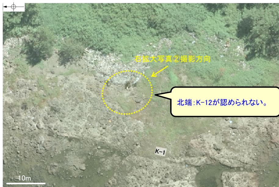
拡大写真① K-12の北方付近
