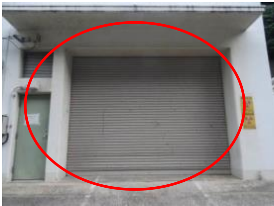
87 固体廃棄物貯蔵庫B棟南西側シャッター（2）
