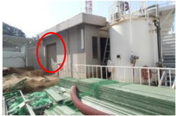
99 鉄イオン貯蔵建物南側シャッター
