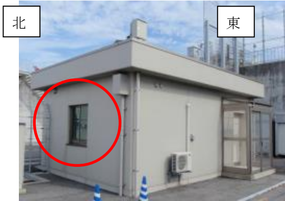
146 東口建物北側ガラス窓
