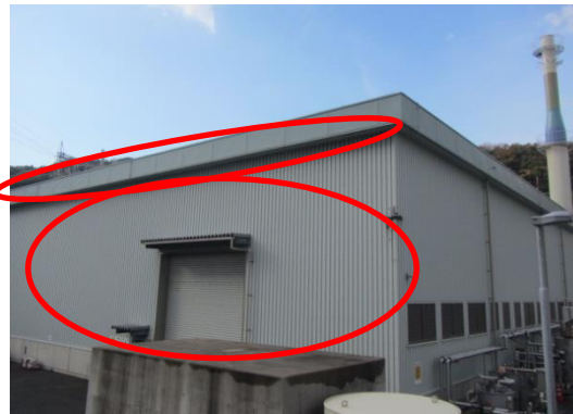
165 3号炉補助ボイラ
