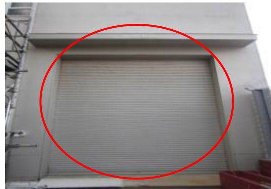
15 補機メンテナンス建物東側シャッター
