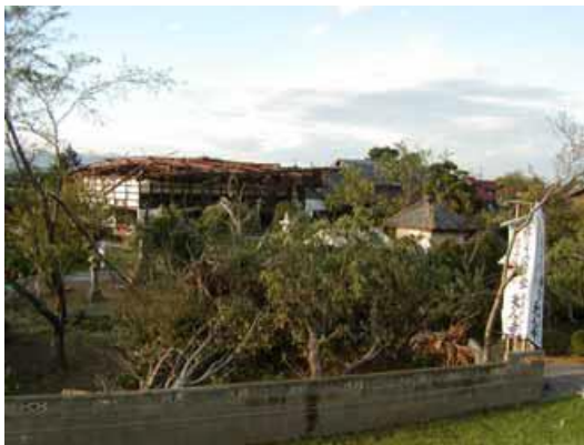
写真1 天神寺外観(南から見る)
