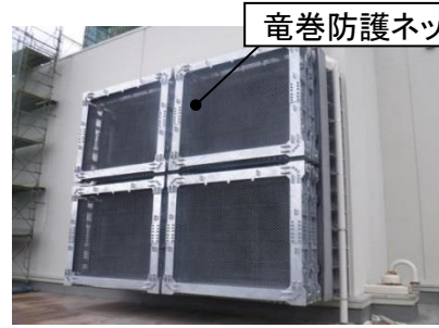
図2 竜巻防護ネットの設置イメージ
