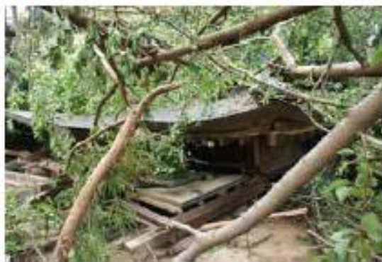
写真 3.5-18 倒木による社の倒壊
