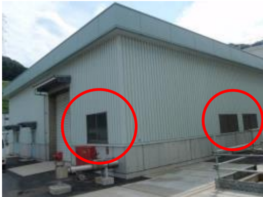
139 給水設備建物東，北側ガラス窓
