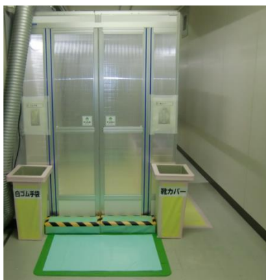
第 6 図 チェンジングエリアの外観
