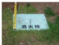
③-10 消火栓蓋
