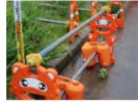
③-2 鋼製車止め (単管バリケード)
