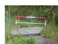
③-9 鋼製フェンス
