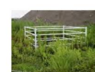
③-12 鋼製フェンス
