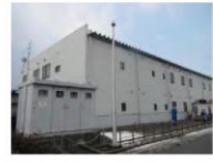
④-1 屋根, 外壁
