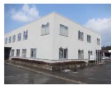
④-11 窓ガラス
