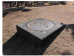
#186 マンホール蓋
