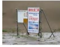
③-33 工事看板
