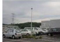
④-6 屋外照明
