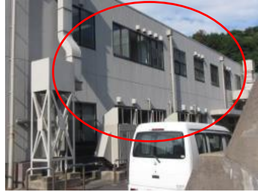
52 事務者 3 号館ガラス窓
