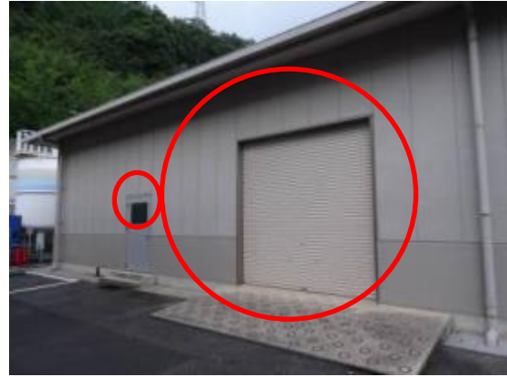
81 2号ろ過水装置建物シャッター，ガラス窓
