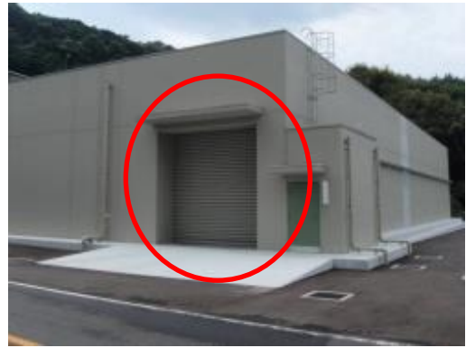
121 固体廃棄物貯蔵所D棟南東側シャッター
