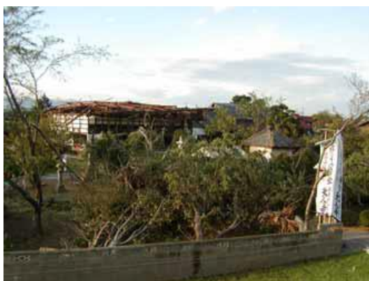
写真1 天神寺外観(南から見る)
