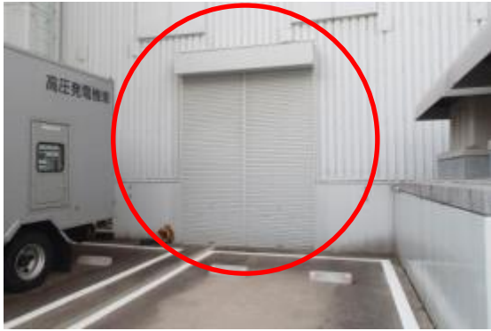
96 1号開閉所南側シャッター
