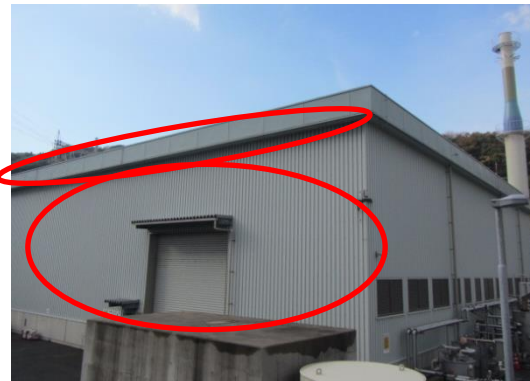
165 3号炉補助ボイラ
