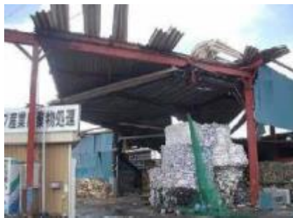
折板の損傷
