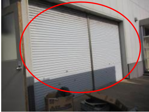
51 事務所 3 号館シャッター
