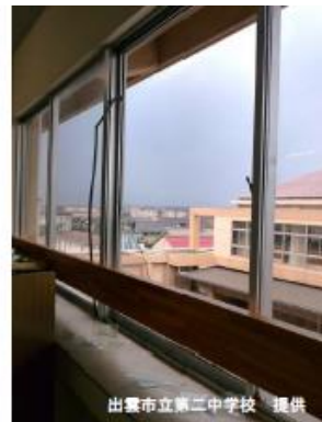
図 25 平成 24 年 2 月 1 日島根県出雲市にて発生した F0 竜巻によるガラス窓の被害状況 ※9
