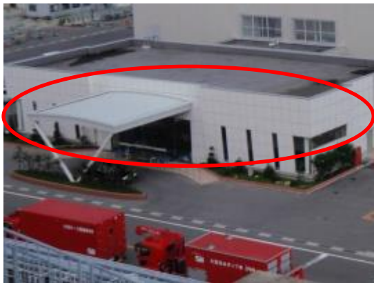
114 出入管理棟南側ガラス窓
