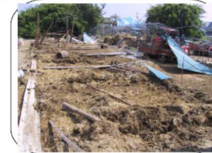
牛舎の屋根東方向、柱・トタン板は西方向に飛散している
