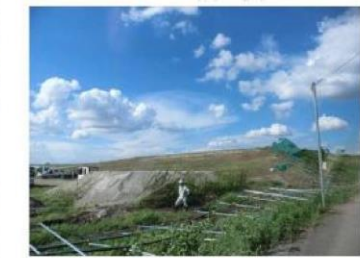
フェンスの倒壊
