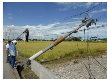
電柱の倒壊
