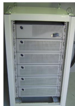
無停電電源装置
