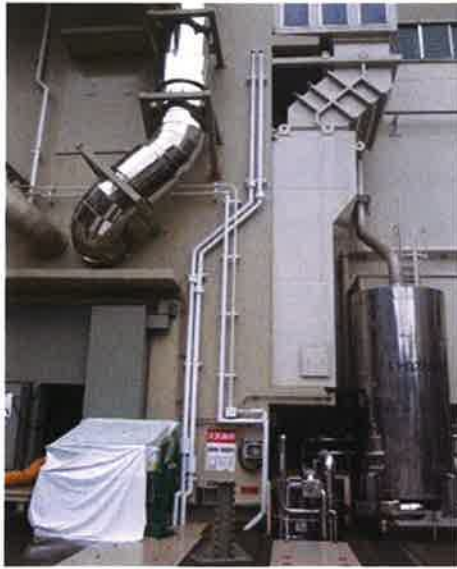
図 2 燃料油貯油そうベント管の外観写真（右は拡大写真）
