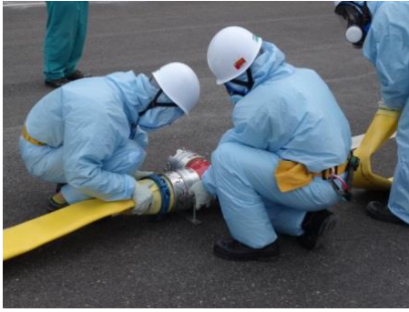
ホース接続作業（昼間）
