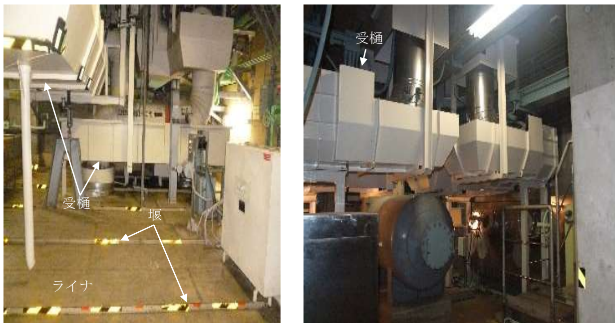
第1図 鋼製のライナ又は受樋の一例
