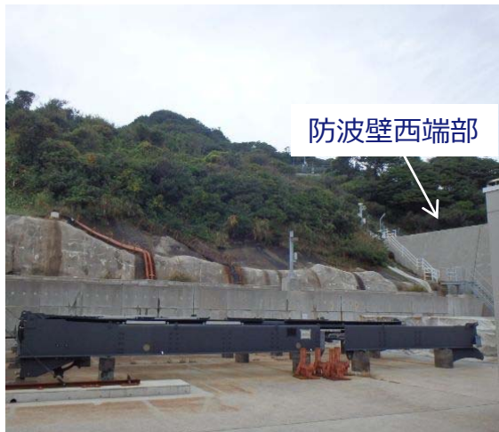
防波壁西端部 状況写真
