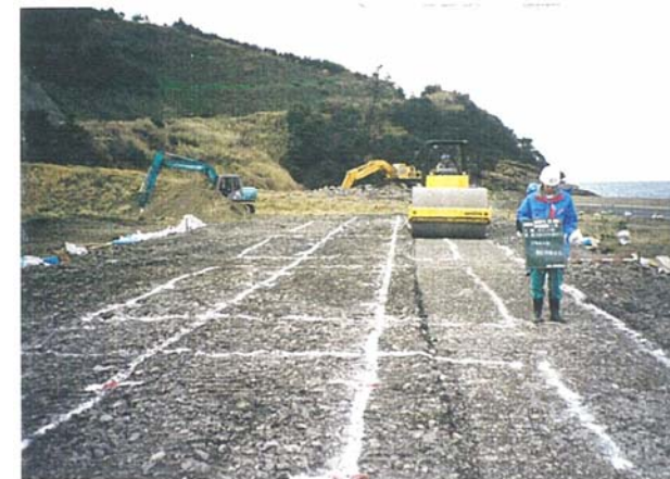
振動ローラによる転圧状況
