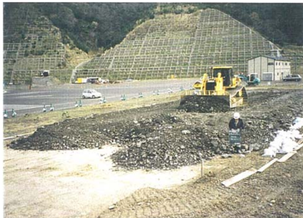
巻き出し整地状況
