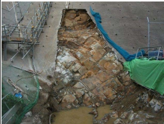
防波壁東端部 岩盤露出状況
