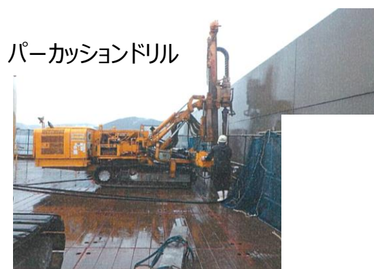
施工状況（削孔工）
