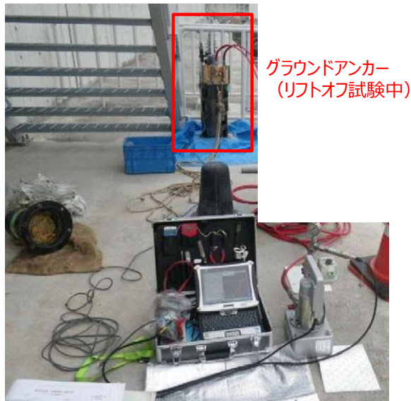
第 6-18 図 防波壁（鋼管杭式逆 T 擁壁）定期点検状況 （リフトオフ試験）
