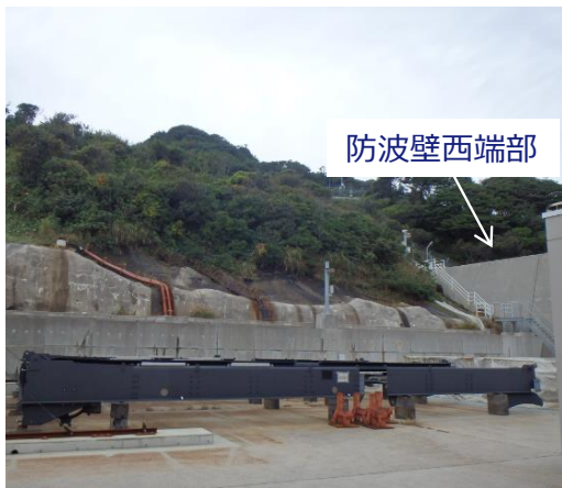
防波壁西端部 状況写真
