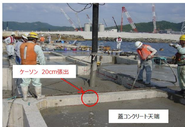
蓋コンクリート打設状況
