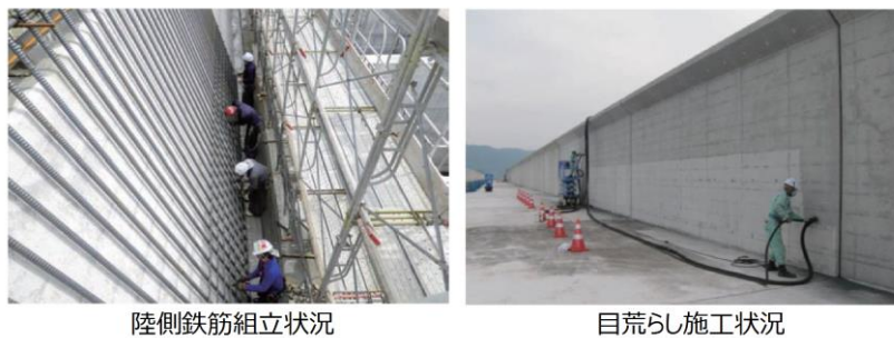
第7-37図 施工状況写真
