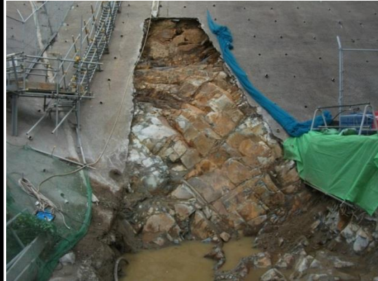
防波壁東端部 岩盤露出状況
