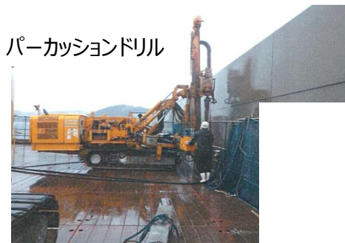
施工状況（削孔工）
