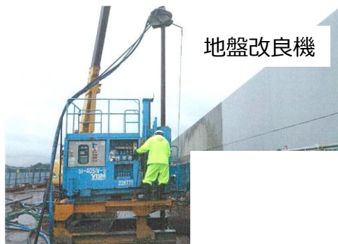
施工状況（造成工）
