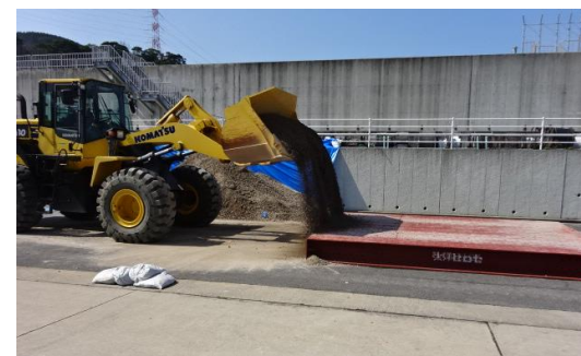
段差復旧状況
