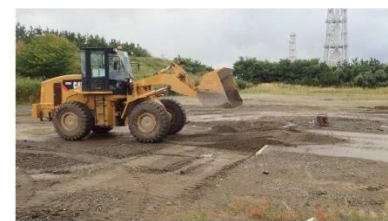
段差復旧状況③
