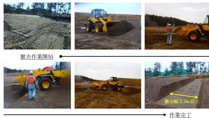
第8図 土砂撤去検証の写真
