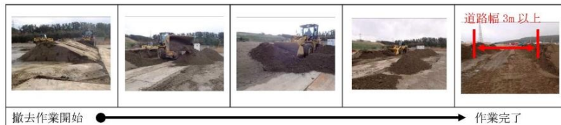
第10図 土砂撤去状況写真
