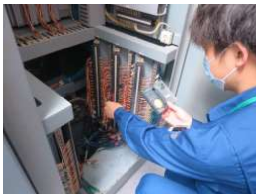
仮設計器による温度確認の一例
