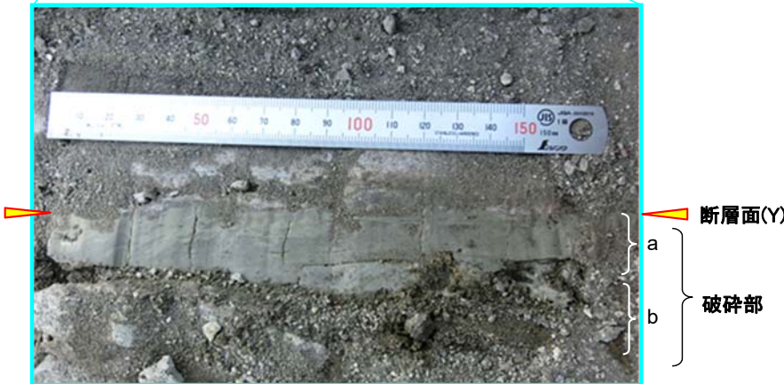
掘削面底盤B画像
