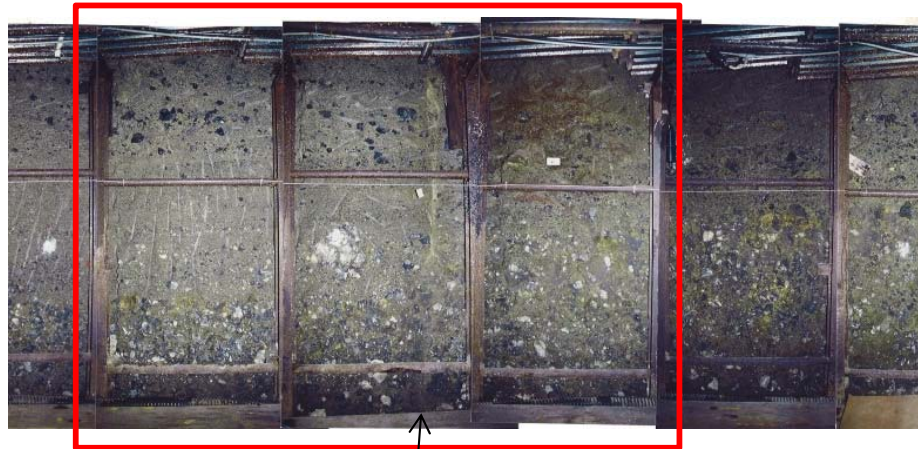
補足調査坑TM-9坑 西側壁 画像・スケッチ
