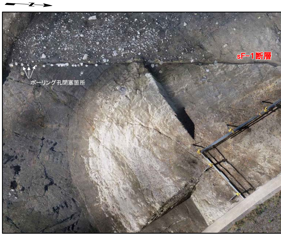
掘削面の写真(上空から撮影)
