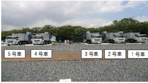
常設代替高圧電源装置（イメージ）
