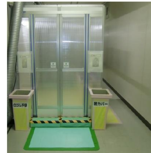
第6図 チェンジングエリアの外観
