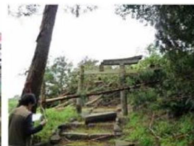
樹木の折損と鳥居の被害
