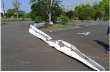
飛散した鋼板製屋根材
