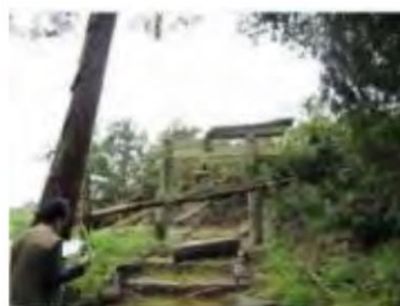
倒木の折損と鳥居の被害
