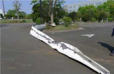
飛散した鋼板製屋根材
