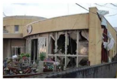
店舗の窓ガラスの被害状況
