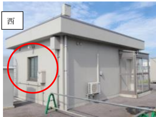
148 北口建物西側ガラス窓
