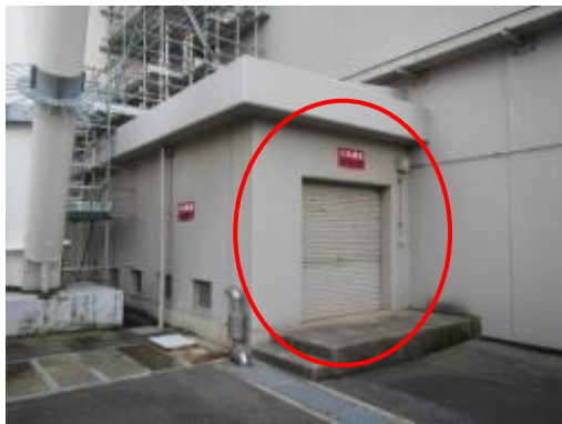
11 2号T/B北東側水素ガスポンベ室シャッター
