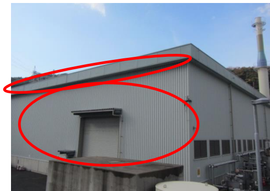
165 3号炉補助ボイラ
