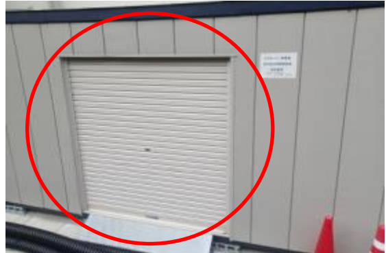
104 ガスタービン発電機資材倉庫南側シャッター
