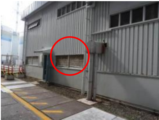
53 純水処理建物給気用格子
