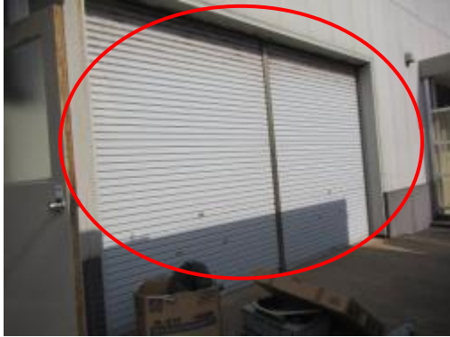
51 事務所 3 号館シャッター
