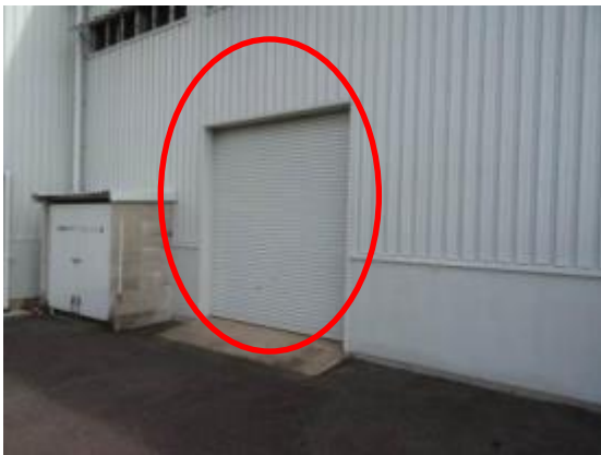
55 補助ボイラー室北側シャッター (2)
