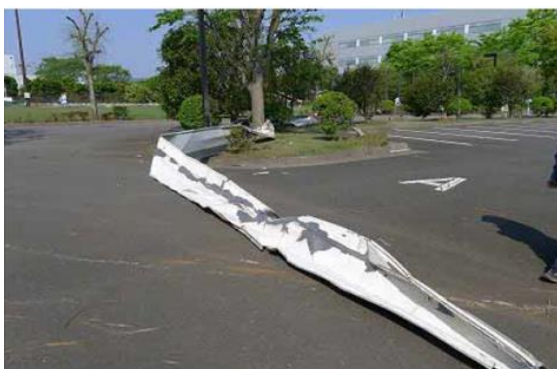
飛散した鋼板製屋根材
