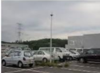
④-6 屋外照明
