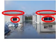
⑤-12 窓ガラス, 屋根
