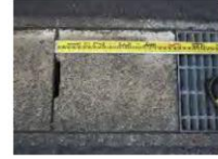
④-3 コンクリート板 (排水溝蓋)
