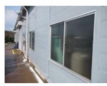
④-12 窓ガラス
