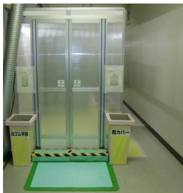
図 3.3-6 チェンジングエリアの外観
