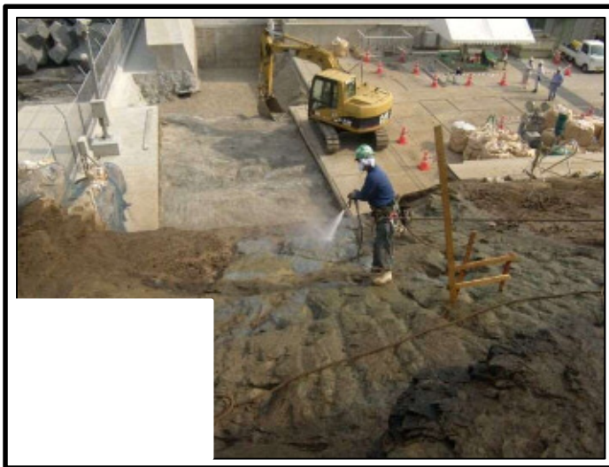
防波壁西端部 岩盤露出状況
