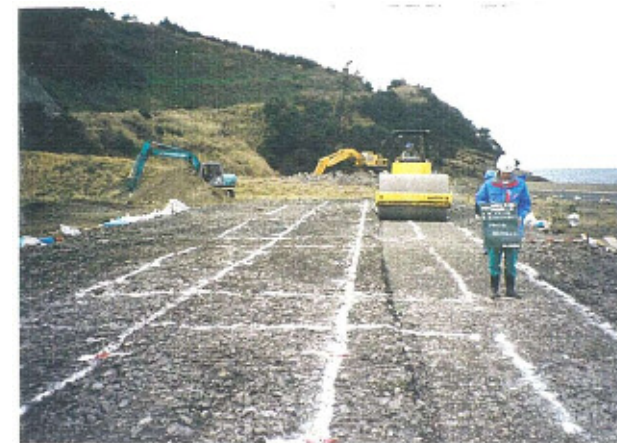
振動ローラによる転圧状況
