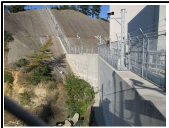
防波壁東端部 外観写真
