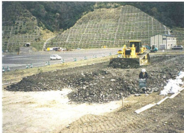
巻き出し整地状況
