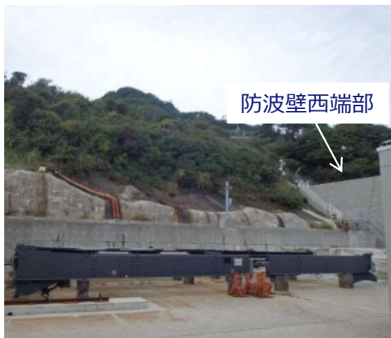
防波壁西端部 状況写真
