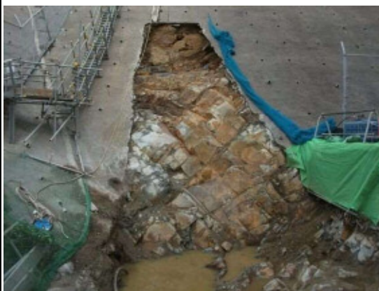
防波壁東端部 岩盤露出状況
