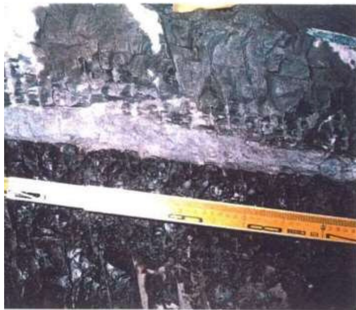
3号炉試掘坑（C-S坑）におけるシーム
