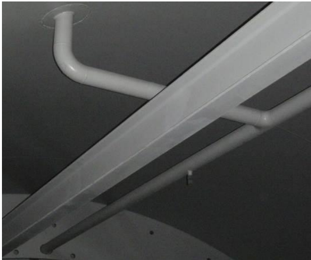
図 2.1.3-2 格納容器スプレイ・ヘッダ敷設状況
