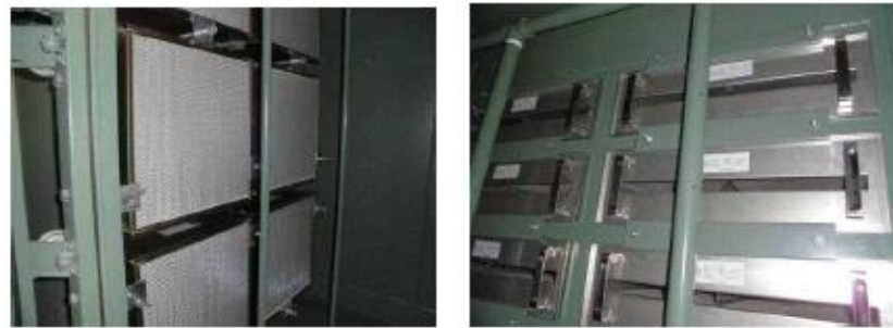
(高性能フィルタの取付け状態) (活性炭フィルタの取付け状態) 図2. 1. 4-10 再循環フィルタの取付け状態
