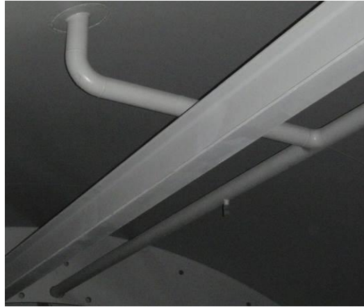
図 2.1.3-2 格納容器スプレイ・ヘッド敷設状況
