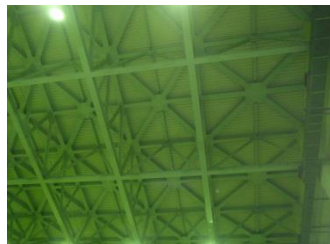
原子炉建物天井
